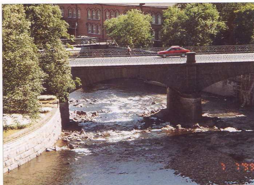
Tammerkoski, joka on patoremontin ja puhdistuksen vuoksi kuivillaan
